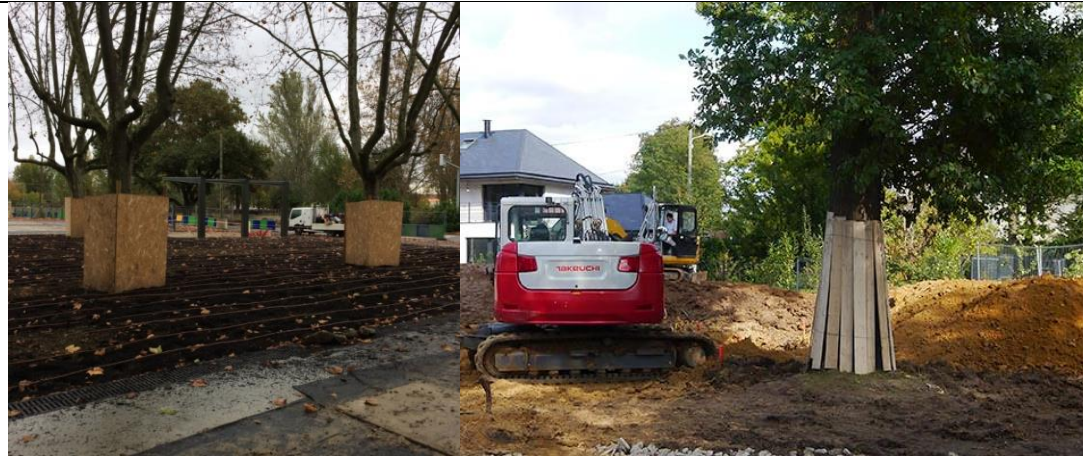
Exemple de protection des arbres à l'aide de planche OSB ou piquet de bois
